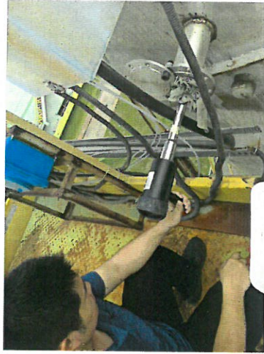
103A 硫化车间排气筒
