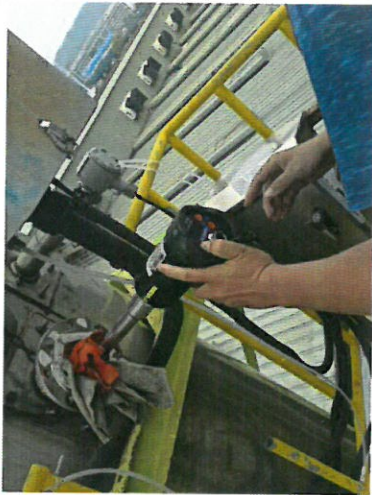
302 硫化车间排气筒 (FQ-440205)
