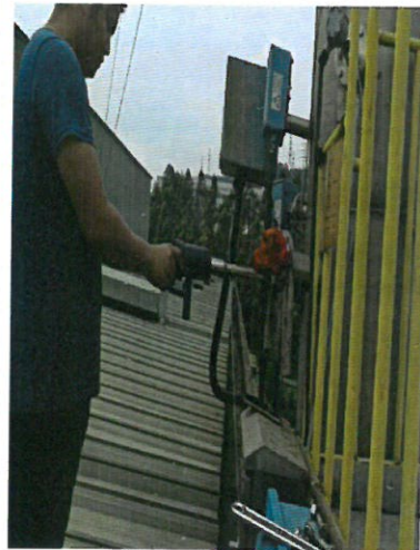
淋幕车间排气筒 (FQ-440202)
