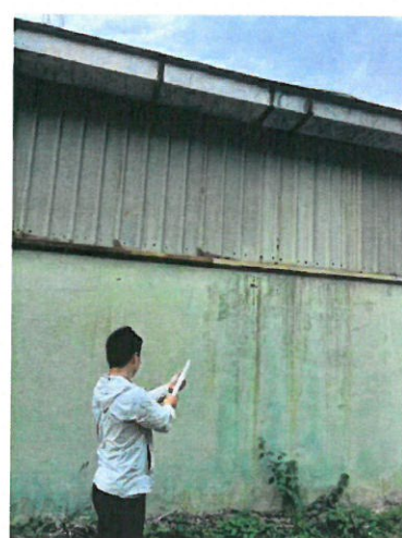
205 车间北侧门外 1 米
