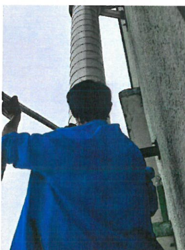
104 检修排气筒出口 (FO-440212)
