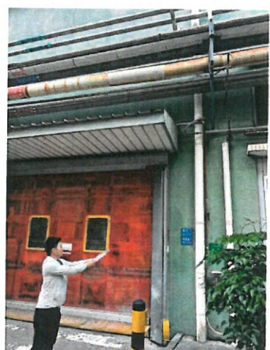
102B 车间南侧门外 1 米
