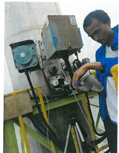
302 硫化废气处理设施出口 (FQ-440205)
