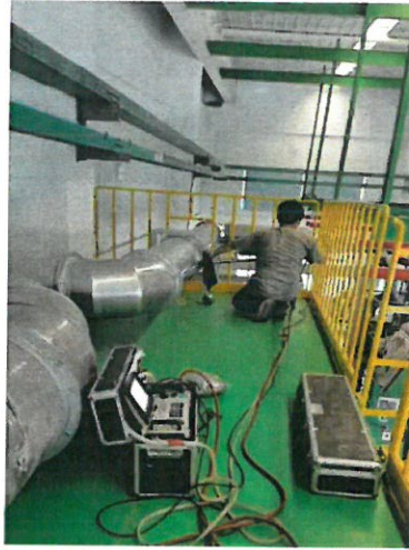
106 配料室排气筒 1#出口 (FO-440215)
