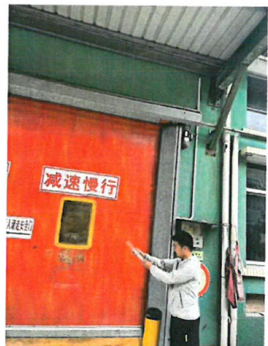
102A 车间南侧门外 1 米
