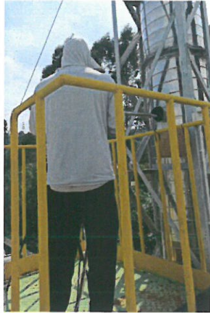
302 检修排气筒出口 (FQ-440213)
