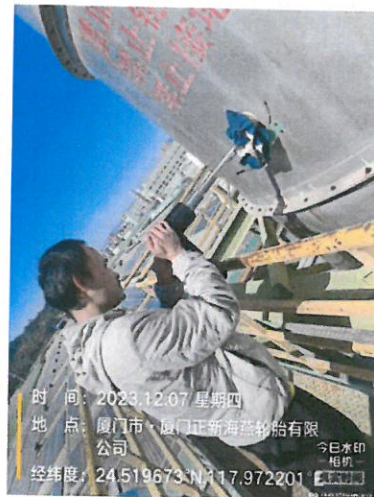
505 硫化车间排气筒出口(DA016)
