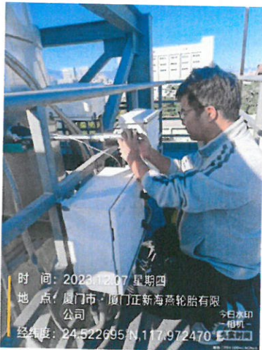
105/205 硫化车间排气筒出口(DA004)
