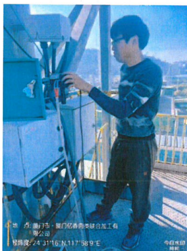
01 混炼车间排气筒出口 (DA001)
