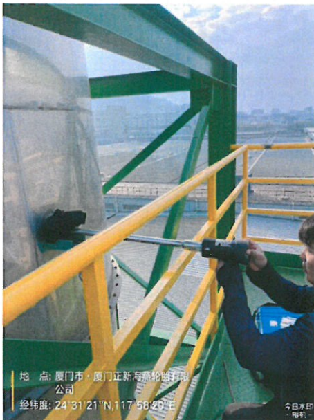
105/205 车间硫化车间排气筒 出口 (DA004)
