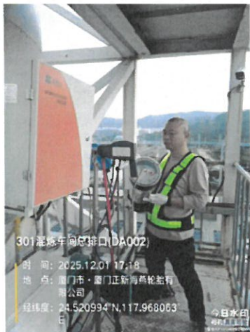
301 混炼车间总排口 (DA002)
