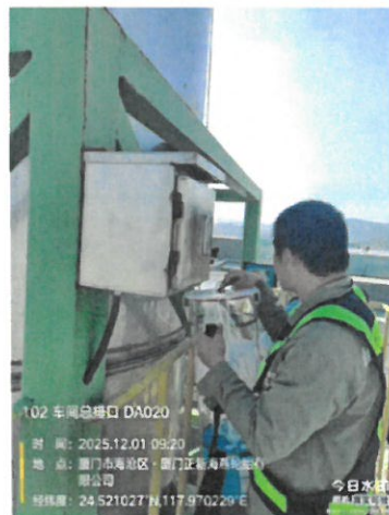
102 车间总排口 (DA020)
