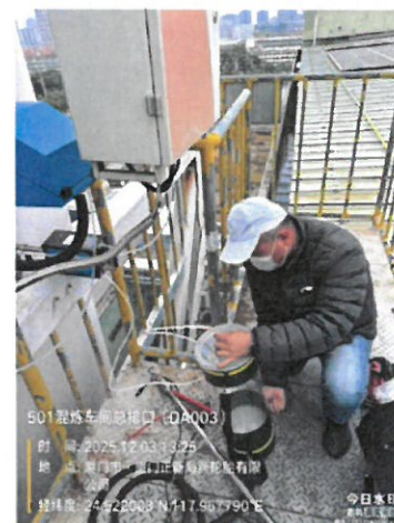
501 混炼车间总排口 (DA003)
