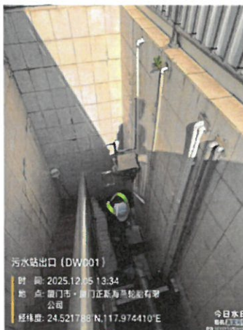
污水站出口 (DW001)
